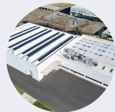
CASTELLAMONTE Siège social et site de contrôle qualité
